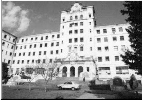
Instituto de Cirugía de Haedo , hoy, Hospital Interzonal General de Agudos de Haedo "Dr. Luis Güemes". La obra se inició el 17 de Noviembre de 1938, finalizando el 30 de Marzo de 1940 y quedando inaugurada oficialmente el 29 de Junio de 1942, siendo gobernador el Dr. Rodolfo Moreno.
