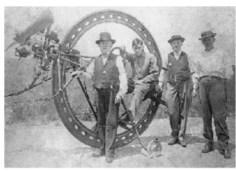
tro de la rueda y por tanto queda fijo. La rueda es metálica y delgada v está revestida con un filete de caucho y posee un par de pequeñas ruedas laterales retráctiles para estabilizar el vehículo detenido. Parece ser una típica invención de amateurs industriales, quizá ese par de señores que pueden regentear un pequeño taller en un pueblo del medio oeste.
