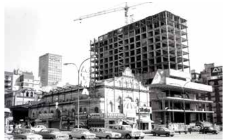
Construcción del Bristol Center. Queda parte del Hotel Bristol, 1972. Carlos Alberto de Ada. Fuente internet.
