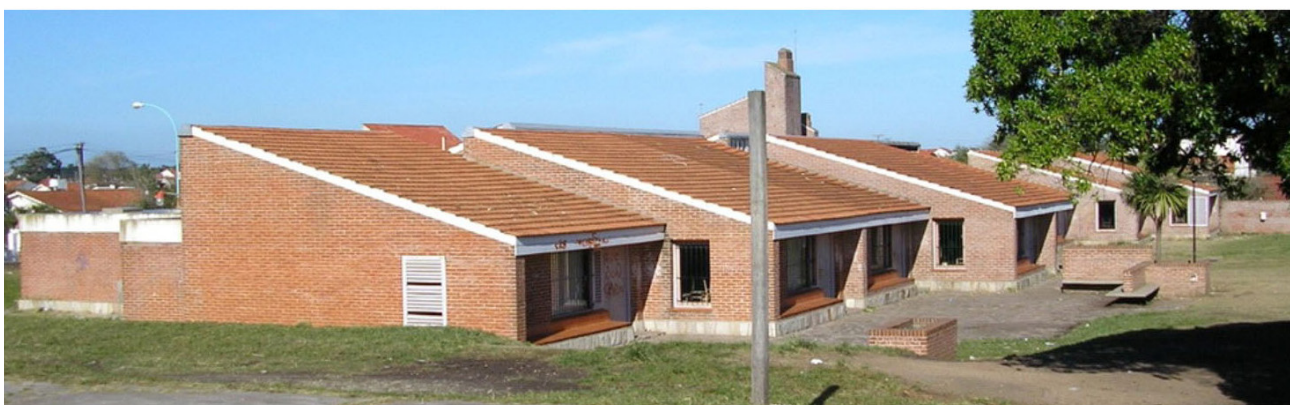
Figura 4. Fotografías de la Escuela N°3 Barrio Faro Norte. Arquitectos J. M. Borthagaray - M. Castellu - C. Marré (1965). Fuente: Archivo Secretaría de Educación, MGP.
