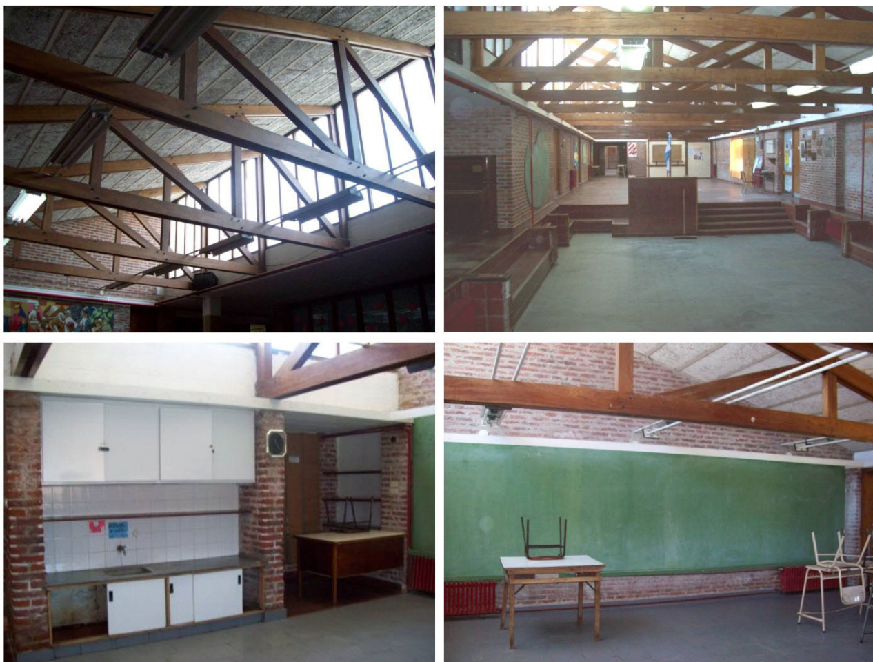
Figura 5. Arriba: Escuela Municipal N° 4, vista del shed de estructura de techo y del patio cubierto. Abajo: Escuela Municipal N° 1, vista del sector docente (escritorio, guardado, mesada húmeda) y de aula tipo.
