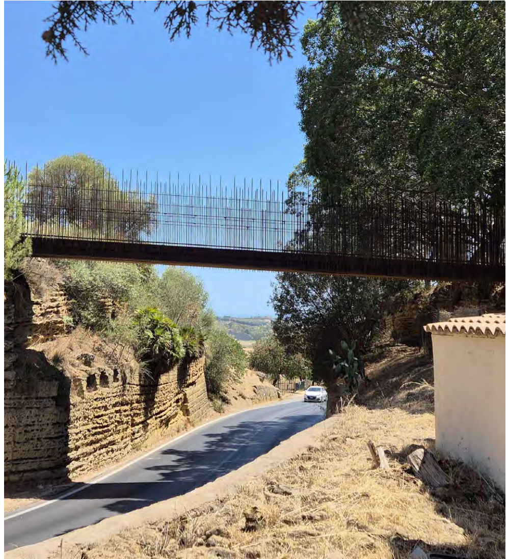
Figura 26. Infraestructura que divide actualmente el Valle de los Templos de Agrigento en dos áreas, unidas mediante una pasarela peatonal.
