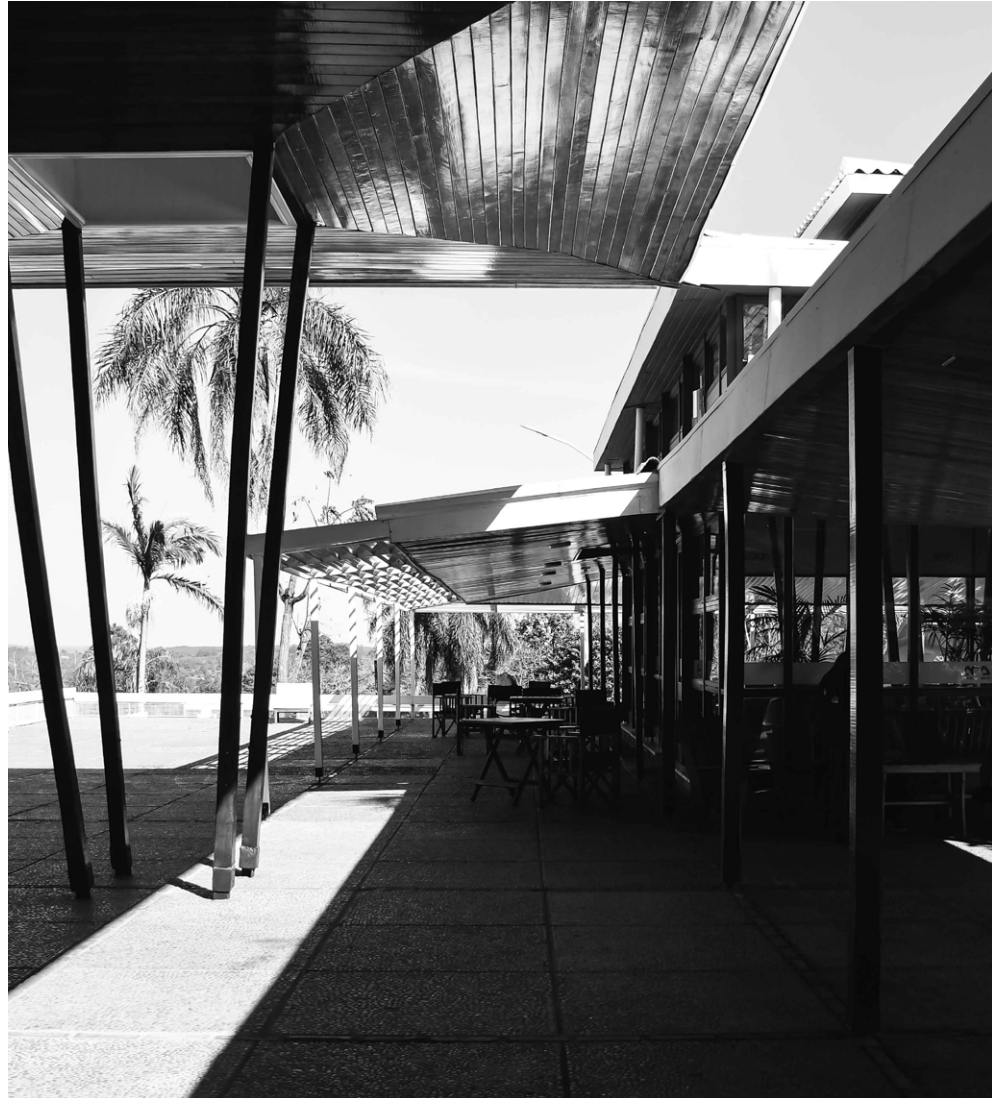
Figura 22. Detalle de la sombra, al exterior, que producen la sombrilla y los aleros. Fuente propia.
