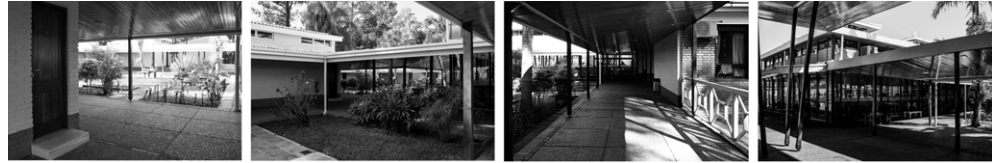
Figura 18. Los distintos aleros y galerías. Se observa la baja altura que permite sombrear fachadas y pisos exteriores. Fuente propia.
