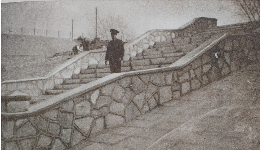
Figura 5. Escaleras. Obtenida en Cuatro años de gobierno. Tomo V. Hidráulica, Pavimentación. Obras Públicas. Geodesia y Catastro.
