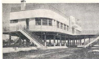
Detalle que permite apreciar el edificio del Balneario construido totalmente sobre columnas de hormigón, cuyo acceso se efectúa por medio de escalinatas con traidas igualmente con hormigón de cemento portland.
