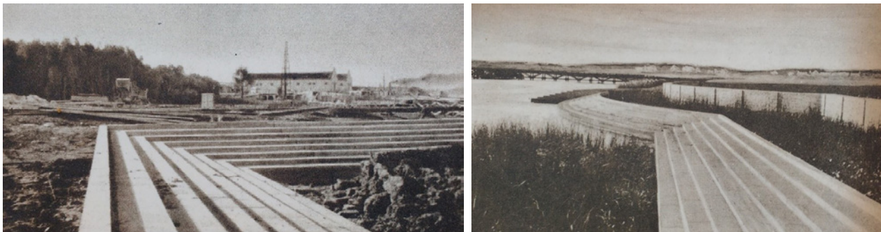
Imágenes 7 (izq.) y 8 (der.). Obras en el Balneario General Uriburu, donde pueden verse la construcción del escalonado de acceso al agua desde el balneario. Fuente: Cuatro años de Gobierno . Tomo V. Hidráulica, Pavimentación. Obras Públicas. Geodesia y Catastro.
