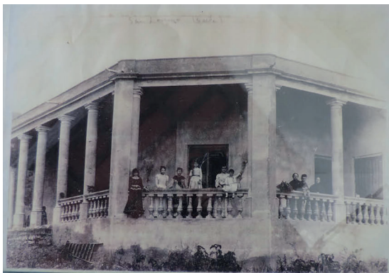
Figura 10. Casas Usandivaras. Vista de la Casa de Usandivaras (propietario original), con líneas italianizantes a principios del siglo XX y una imagen actual, donde se muestra el cambio hacia el neocolonial.
