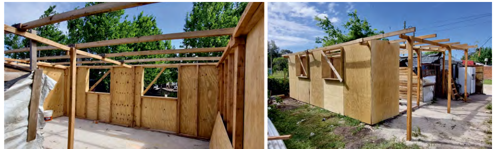
Figura 13. Colocación de bastidores y emplacado parcial. Fuente: Elaboración propia
