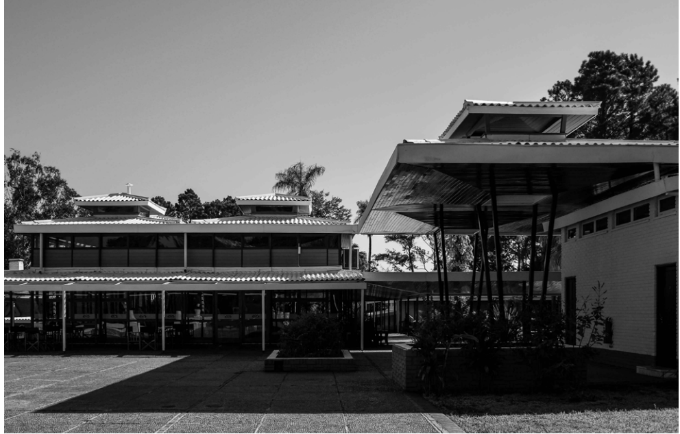
Figura 5. Vista de los aleros y galerías que sombream el perímetro exterior del edificio y posibilitan las transiciones con el espacio exterior. Fuente: propia.
