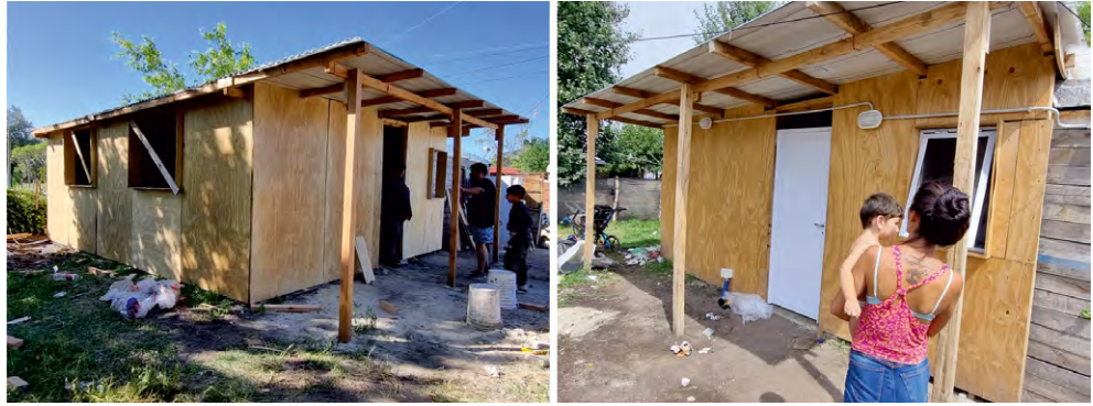
Figura 16. Colocación de aberturas.
