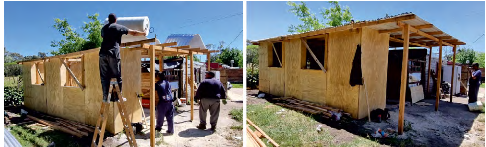
Figura 14. Ejecución de cubierta Fuente: Elaboración propia
