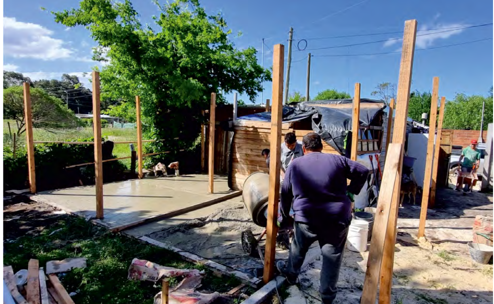
Figura 12. Llenado de contrapiso con AFR.
