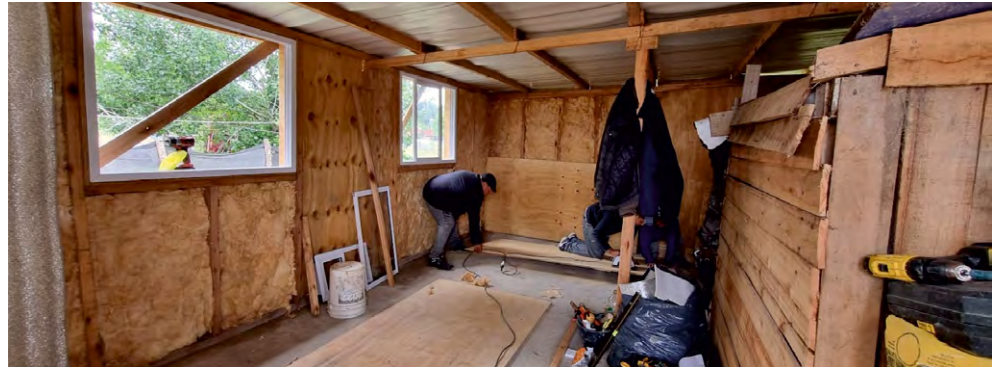
Figura 15. Colocación de aislamiento termoacústica y panelizado interior.
