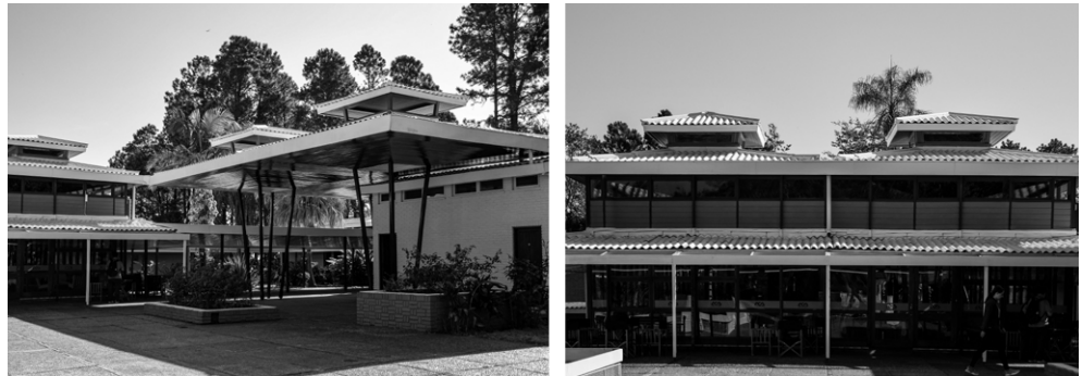
Figura 15. Detalle exterior de las sombrillas, puede observarse las envolventes de fibrocemento y madera; como el sombrerete por donde se disipa el aire caliente. Fuente propia.
