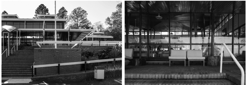
Figura 17. Detalle del alero de ingreso. Fuente propia.
