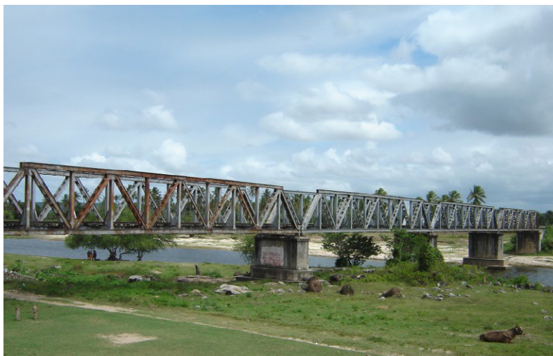
Figura 3. Ponte metálica sobre o Rio Curimataú Acervo próprio.
