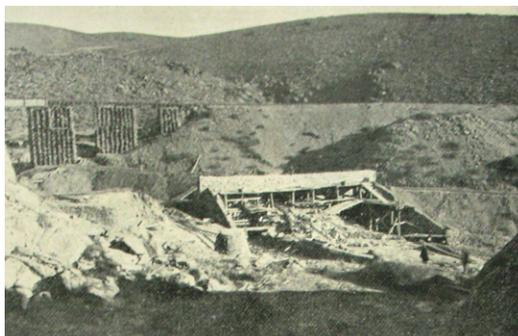
Figura 5a. Bóveda de 10 metros de luz en el km. 508. Característica de las grandes lomas y altas mesetas patagónicas (p. 27). El ferrocarril al Lago Nahuel Huapi. Estado Actual de las Construcciones. Tráfico y Turismo, (1927, jun.). Riel y Fomento, 62, 27-29.
