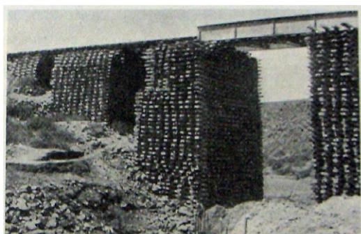
Figura 5c. Uno de los varios puentes provisorios en la zona del cañadón (p. 28). El ferrocarril al Lago Nahuel Huapi. Estado Actual de las Construcciones. Tráfico y Turismo, (1927, jun.). Riel y Fomento, 62, 27-29.
