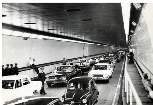
Figura 9. Túnel Subfluvial. Interior. S/f. AGN.
