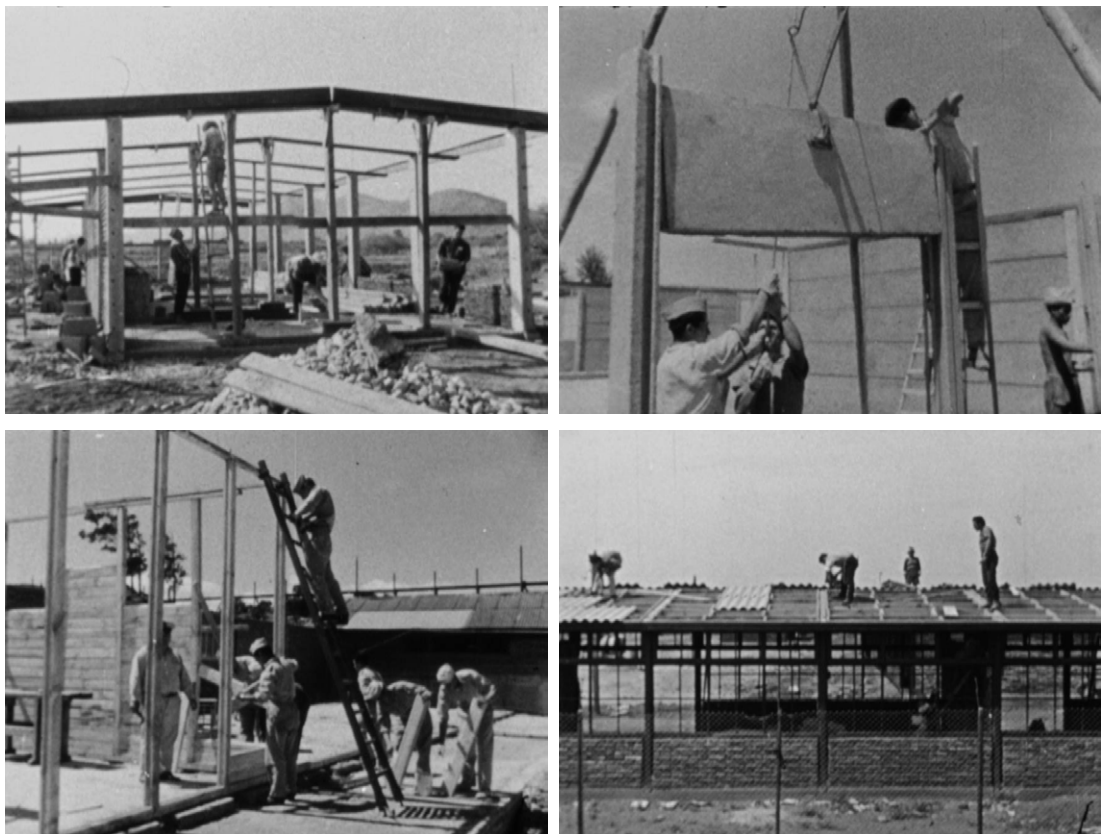
Figuras 5-8. Fotografías que muestran la utilización de diferentes sistemas constructivos en la construcción de escuelas. Fig. 5. Sistema constructivo con pilares de hormigón y vigas en acero (no identificado); fig. 6. Sistema constructivo Dobal con pilares y placas de hormigón; fig. 7. Sistema constructivo Servanti en madera; fig. 8. Sistema constructivo MC en acero, de la Sociedad Constructora de Establecimientos Educativos. Cortometraje Chile en marcha: educación para todos . Archivo audiovisual de la Casa Museo Eduardo Frei Montalva.
