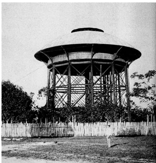
Figura 5. Caixa de Água de São Brás. Sua estrutura em ferro foi importada da Europa, tornou-se marco visual e símbolo de modernidade em Belém. Disponível em: http://www.forumlandi.ufpa.br/biblioteca-digital/foto/caixa-dagua-de-sao-braz-em-1898 .
