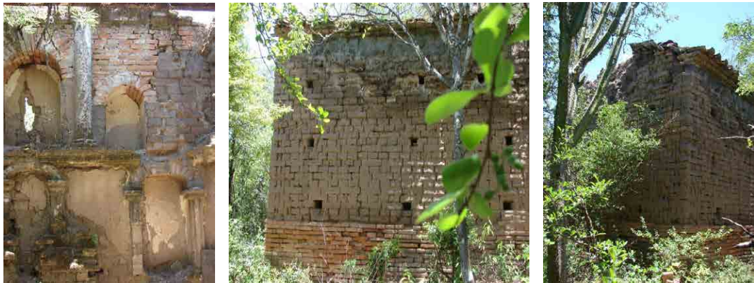
Figuras 10. (de izquierda a derecha) Vista del retablo con sus hornacinas, del muro exterior y encuentros de muros con un sector de la cubierta de tejas (Fotografías de Santoni, M).
