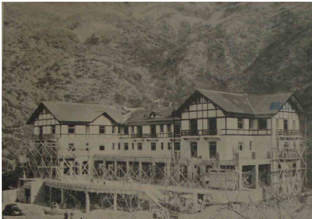
Figura 6. Vista de la obra del hotel de Villavicencio ("Ferrocarril Buenos Aires al Pacífico," 1940, p. 64).
