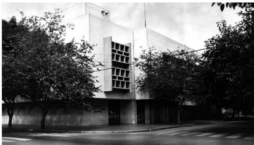
Fig.1 Sindicato de Luz y Fuerza. Sobre el Hall de ingreso se encuentra la sala de proyecciones sostenida por una audaz estructura de hormigón armado, consistente en una viga de 4 metros de altura, apoyada en dos puntos. (Juan Augusto Bruggiavini)
