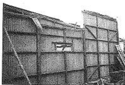
Figura 11: Panel de una vivienda en demolición. Fuente: Archivo personal.
