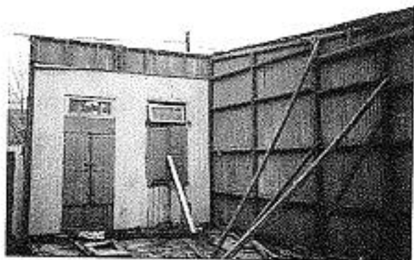
Figura 10: Paneles de una vivienda en demolición Fuente: Archivo personal.
