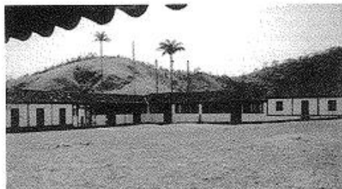
Fig. 2. Fazenda Pau d'Alho, São José do Barreiro. Nota a estrutura autônoma de madeira, compondo o sistema de "gaiolas", desenvolvido em Portugal e trazido para o Brasil através dos imigrantes portugueses vindos para Minas Gerais, no ciclo do ouro. Fonte: foto da autora, 2000.
