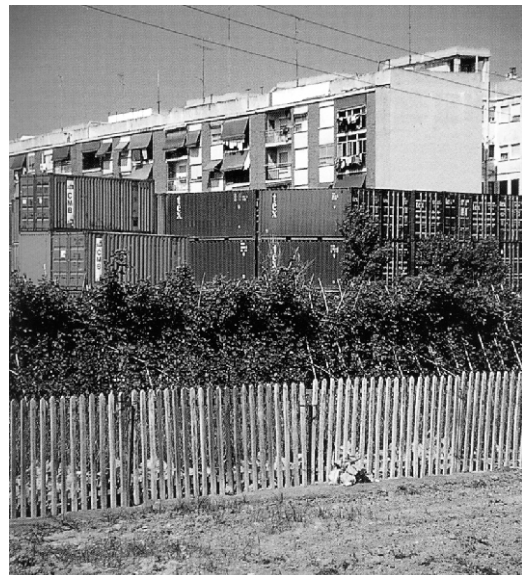
Figura 5. La estrategia de ocupación de suelo de algunos puertos pasa por el depósito ilegal de contenedores. Valencia.
