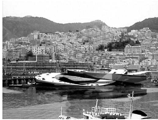
Figura 8. Mil años de historia arrasados por una infraestructura. Génova
