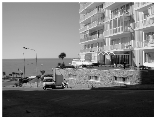
Figura16. Detalle del acceso del edificio San Francisco IV.. Fuente: archivo personal
