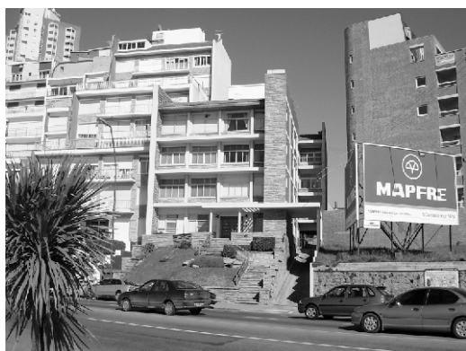
Fig. 10 Detalle del acceso del edificio San Francisco I Fuente: Elaboración propia.
