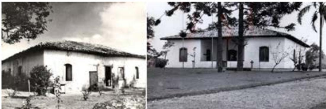
Figura 7. Respectivamente, da esquerda para direita, fotografias do estado de conservação da Casa Bandeirista do Butantã antes do restauro de Luis Saia (esq.) e seu resultado (dir.). Destacam-se a reformulação quase completa dos elementos originais e o aspecto de novo conferido ao edifício após o término das obras. Arquivo do DPH, In Mayumi, 2017, pp. 80-81.
