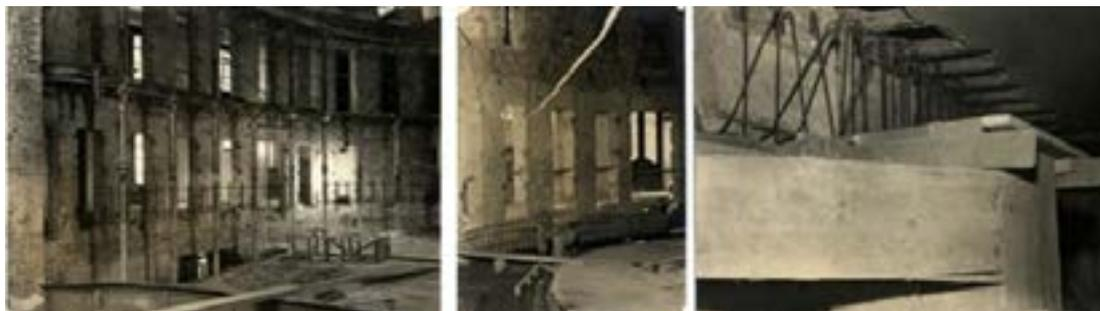
Figuras 13. Respectivamente, demolição dos setores originais da sala de espetáculos (esq.), construção de nova laje em concreto armado (centro) e armação da nova estrutura perimetral (dir.). Acervo de Fotografias do Arquivo Histórico Municipal de São Paulo.
