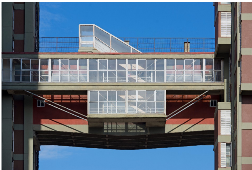
Figura 16. Conjunto Rioja. Vista de los puentes entre las torres. Gentileza del autor de la fotografía, Alejandro Goldemberg.
