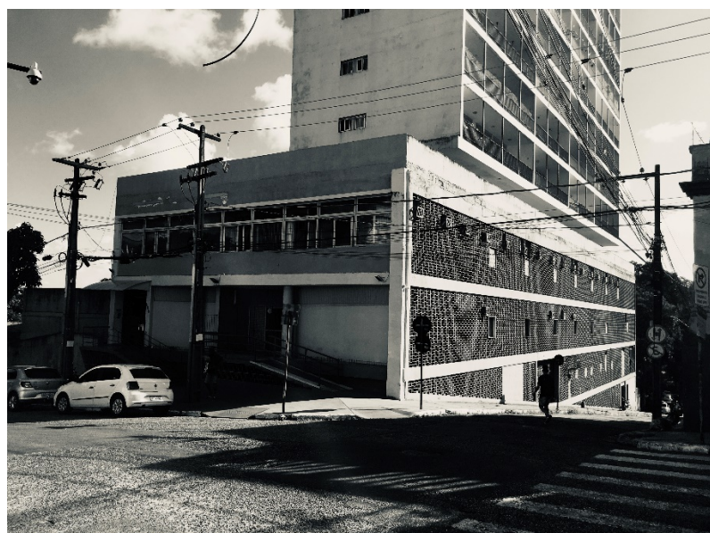
Figuras 8 e 9. O Edifício Presidente João Pessoa em seu estado atual. Acervo do autor.
