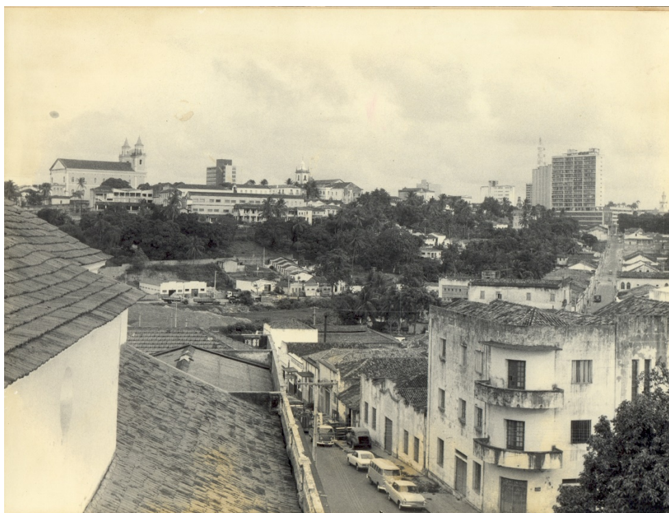
Figura 5. Vista do Edifício Presidente João Pessoa desde a região do Varadouro, centro histórico da capital paraibana, com a fachada norte da lâmina residencial sobre a base criada pelo bloco institucional horizontal, final da década de 1960. Acervo Humberto Nóbrega.
