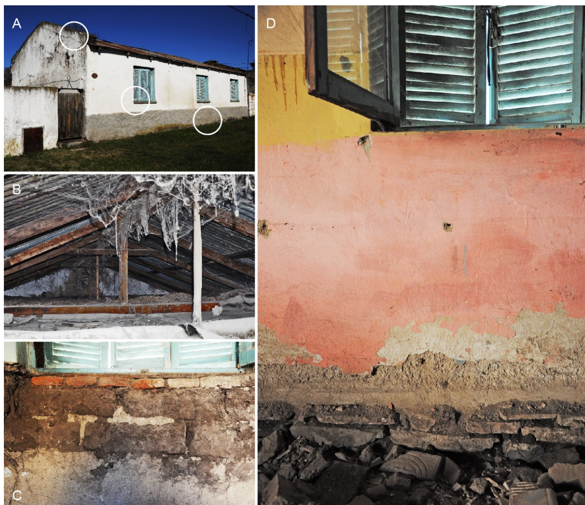
Figura 3. A. Vivienda en Colonia San Miguel. B. Detalle del techo donde se aprecia la estructura de madera que habría formado parte del corte de rancho y el empleo de paja de trigo como aislante térmico. C. Detalle del sector del alfeizar, donde se aprecia el muro de mampostería de adobe. D. Detalle del cimientto de los muros donde se aprecia la mampostería de piedras planas.
