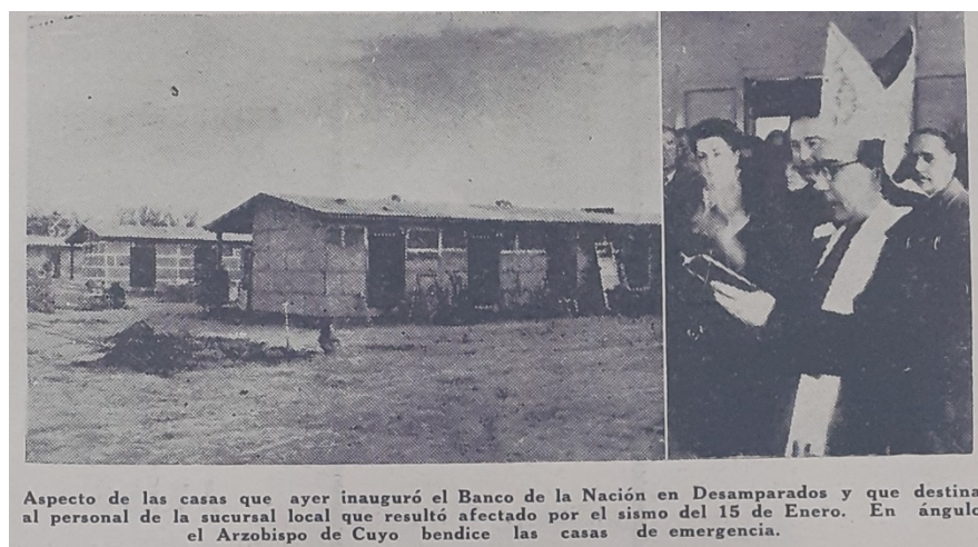
Figura 5 y 6. En estas imágenes se puede apreciar las distintas calidades de casillas. Por un lado, las entregadas a empleados/as del Banco Hipotecario y, por otro, las de empleados/as del Banco Nación. La Acción , 4 de julio de 1944, p. 5. Figura 6. Fue inaugurado ayer el barrio de empleados del banco de la nación argentina, 7 de junio 1944, p. 5
