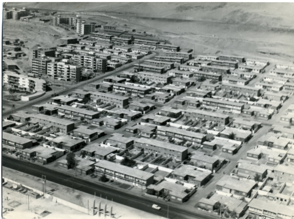
Figura 9. Vista aérea de los sectores 1 y 4 de casas en hileras y pareadas, previo a la incorporación de los edificios Huanchaca y Caliche, y de la torre. Archivo de El Mercurio de Antofagasta .
