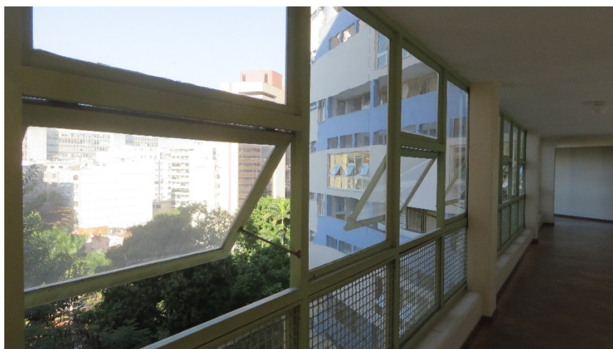
Figura 3. Edifício Júlio Barros Barreto, vista do corredor social e da fachada posterior. Foto de Mara Oliveira Eskinazi, 2017.
