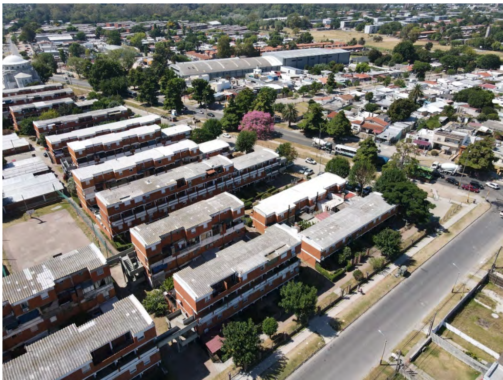
Figura 10. Cooperativa José Pedro Varela, zona 6. Vista del conjunto a vuelo de dron, con las calles elevadas en las tiras de dúplex sobre dúplex. Créditos Martín Cajade, 2023.
