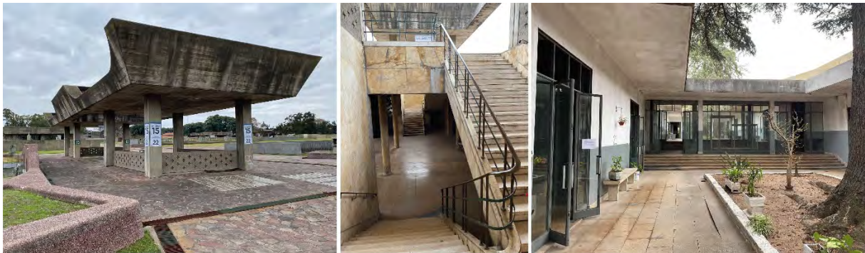
Figura 6. Fotografías actuales del templete de acceso al Panteón de la Sección D1, detalle de caja de escalera y vista interior del patio en subsuelo. Fotografías del autor.
