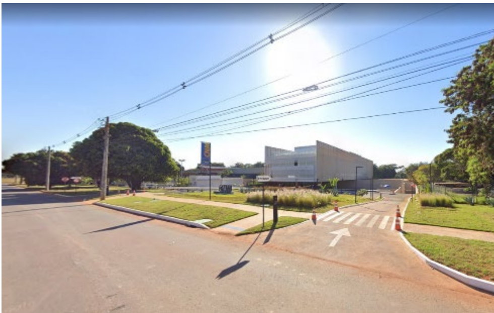
Figura 16. Projeto construído da sede da CNM-DF. Google Street View, 2021 . Acesso em 2023.
