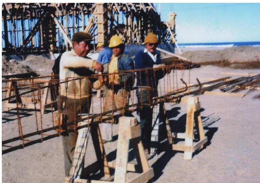
Figura 21. Armado de armadura de hierro del Complejo Balneario Punta Mogotes. Gentileza del Sr. Pablo Roda.
