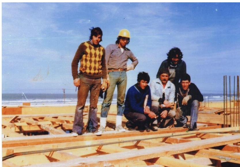
Figura 20. Trabajadores armando encofrado para estructura de hormigón armado. Gentileza del Sr. Pablo Roda.
