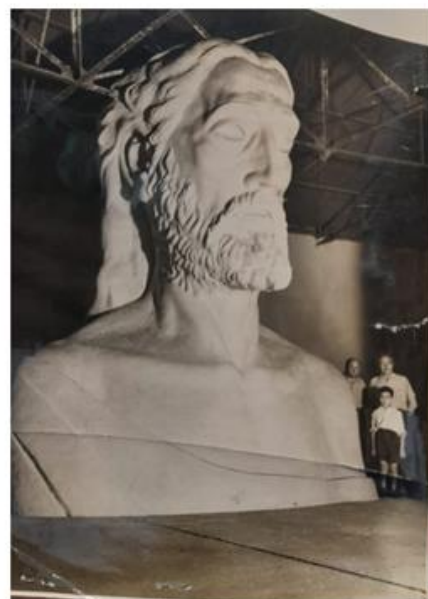
Figura 4. A la izquierda: Cristo Bendicente en la cima del cerro de San Javier. La Prensa , 9 de diciembre de 1945, s.p. A la derecha: Busto del Cristo Bendicente en su etapa de construcción (1941). Museo Iramain. Tucumán.
