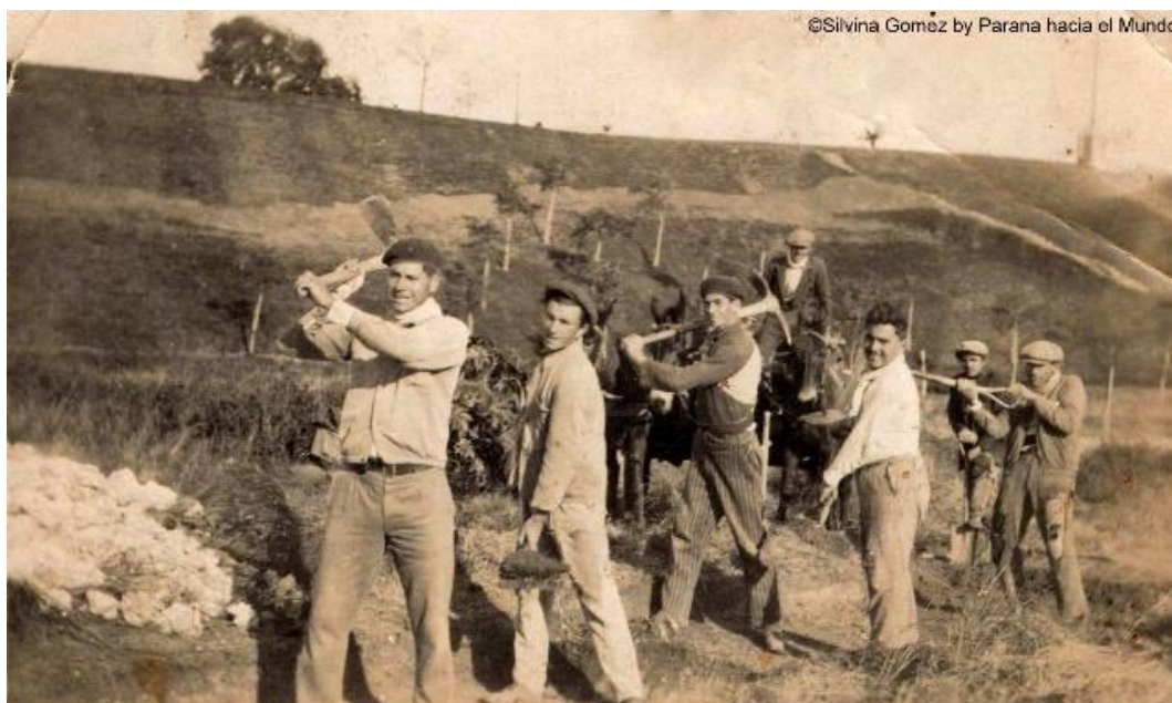
Figura 2. Obreros de la Comisión Pro-desocupados trabajando en la construcción del parque, 1933. Archivo personal Silvina Gomez. Paraná Hacia el Mundo.
