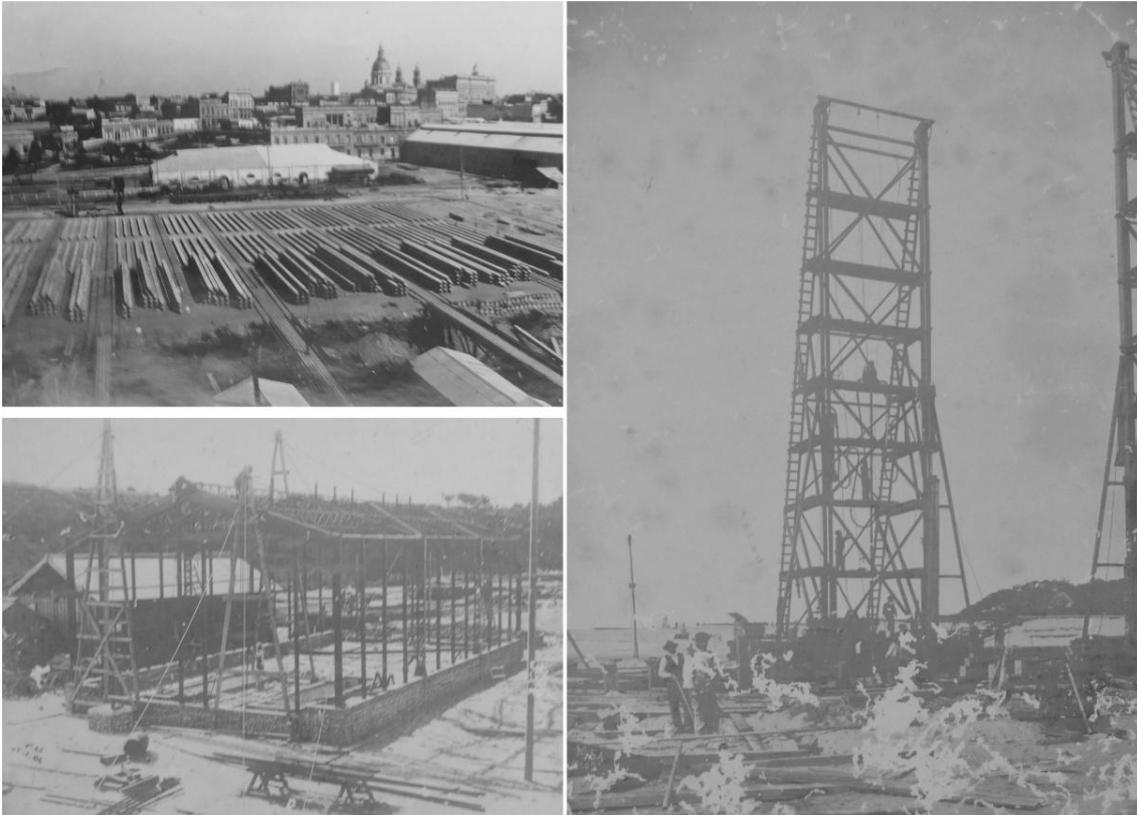
Figura 5. Construcción del puerto: obrador de pilotes; hincado de pilotes (1905) y construcción de estructura de galpones. Archivo Mongsfeld.
