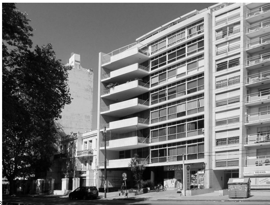
Figura 2. Fotografía de la fachada frontal del edificio Gilpe. Foto del autor.
