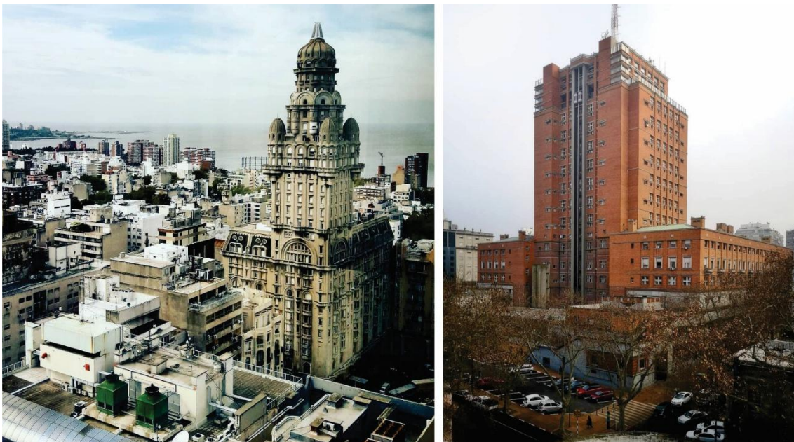
Figura 1. Palacio Salvo sobre su entorno (izquierda) y fachada posterior del Palacio Municipal (derecha). Fotografías del autor.
