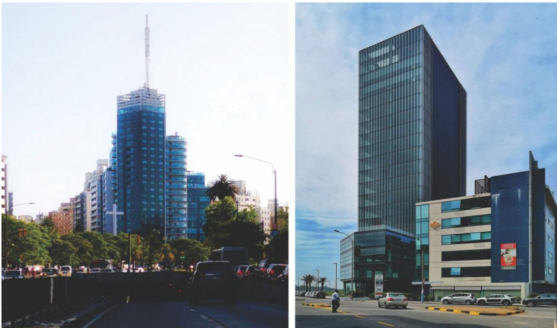
Figura 7. Torre del Congreso en la zona de Tres Cruces (2007, izquierda) y Edificio Plaza Alemania (2008-2019, derecha), ambos evidenciando reglas articuladoras. Fotografía del autor.
