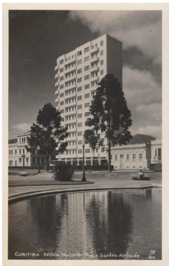
Figura 3 Cartão postal de Curitiba com fotografia do edifício Marumby, 1950. Foto de Alberto Lopes Leiloeiro.
