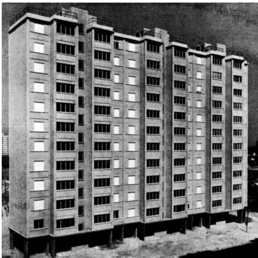
Figura 1. Conjunto habitacional del Barrio Nágera en construcción. Nuestra Arquitectura (1965), 424, p. 453
