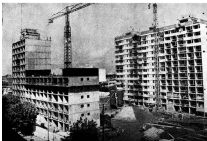
Figura 4. Construcción de monobloques en Barrio Constitución con sistema Outinord, Pueyrredón construcciones (1965). Nuestra Arquitectura , 425, p. 57.
