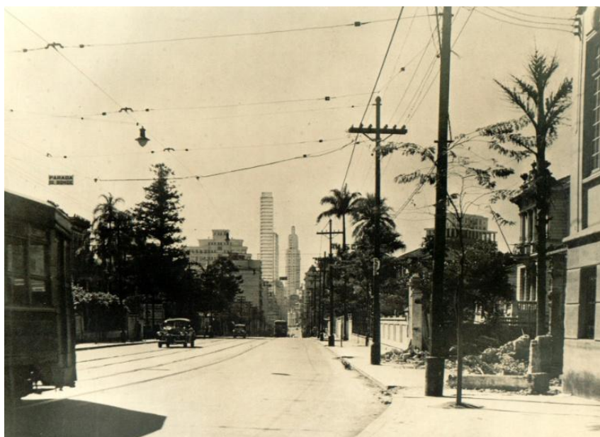
Figura 10. Giancarlo Palanti. Edifício no Largo São Francisco, São Paulo, 1951. Arquivo Giancarlo Palanti, Acervo da Biblioteca FAUUSP, São Paulo.
