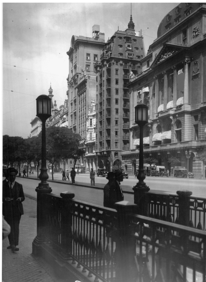
Figura 14 "Entrada de subte Lacroze, estación Alem. En segundo plano vista de la Avenida Alem", Colección AGN 188445, C 70
