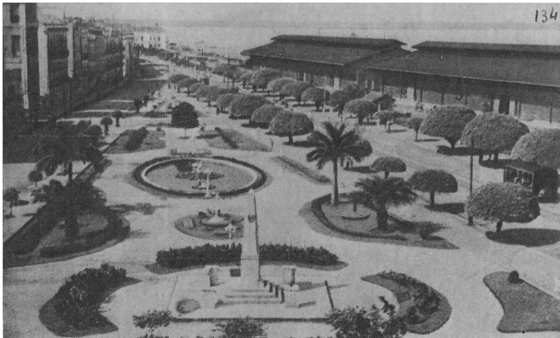
Figura 17. Vista do Boulevard Castilhos França. Esta avenida se tornou possível após as obras de aterro e saneamento da orla portuária da cidade pela empresa Ports of Pará que pertencia ao magnata americano Percival Farquhar. Instituto Brasileiro de Geografia e Estatística (IBGE). Disponível em https://biblioteca.ibge.gov.br/biblioteca-catalogo.html?id=42419&view=detalhes .
