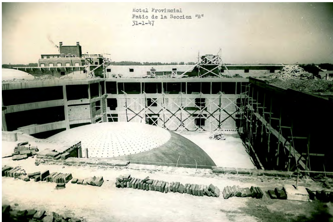
Figura 7. Alejandro Bustillo. Hotel Provincial Mar del Plata. Estructura de la cúpula. 1947. FAB, ADT, UTDT.
