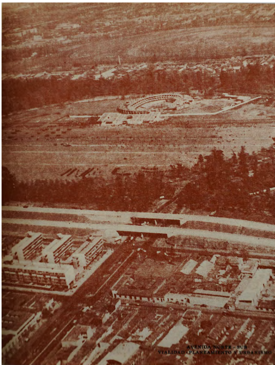
Figura 2. Paso sobre nivel Avenida Matta-Autopista circa 1966. Ministerio de Obras Públicas
